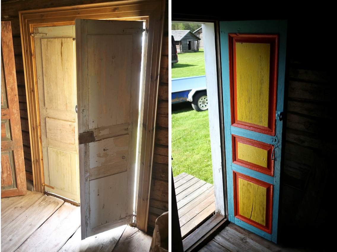
Kuva 26: Ovet maalattiin kolmeen kertaan ohuesti, ensin tärpätillä ohennetulla maalilla ja sitten kahdesti ohentamattomalla. Sisäpuolelta ovien uudella puulla paikatus kohdat maalattiin kertaalleen titaanivalkoisella, jota patinoitiin maalin kuivuttua. Näin paikkauskohdat eivät nouse turhan voimakkaasti esiin. Muuten sisäpuolen maalaukset jäivät entiselleen, kuitenkin niin, että kaikki löyhällä oleva maali kaavittiin pois.
