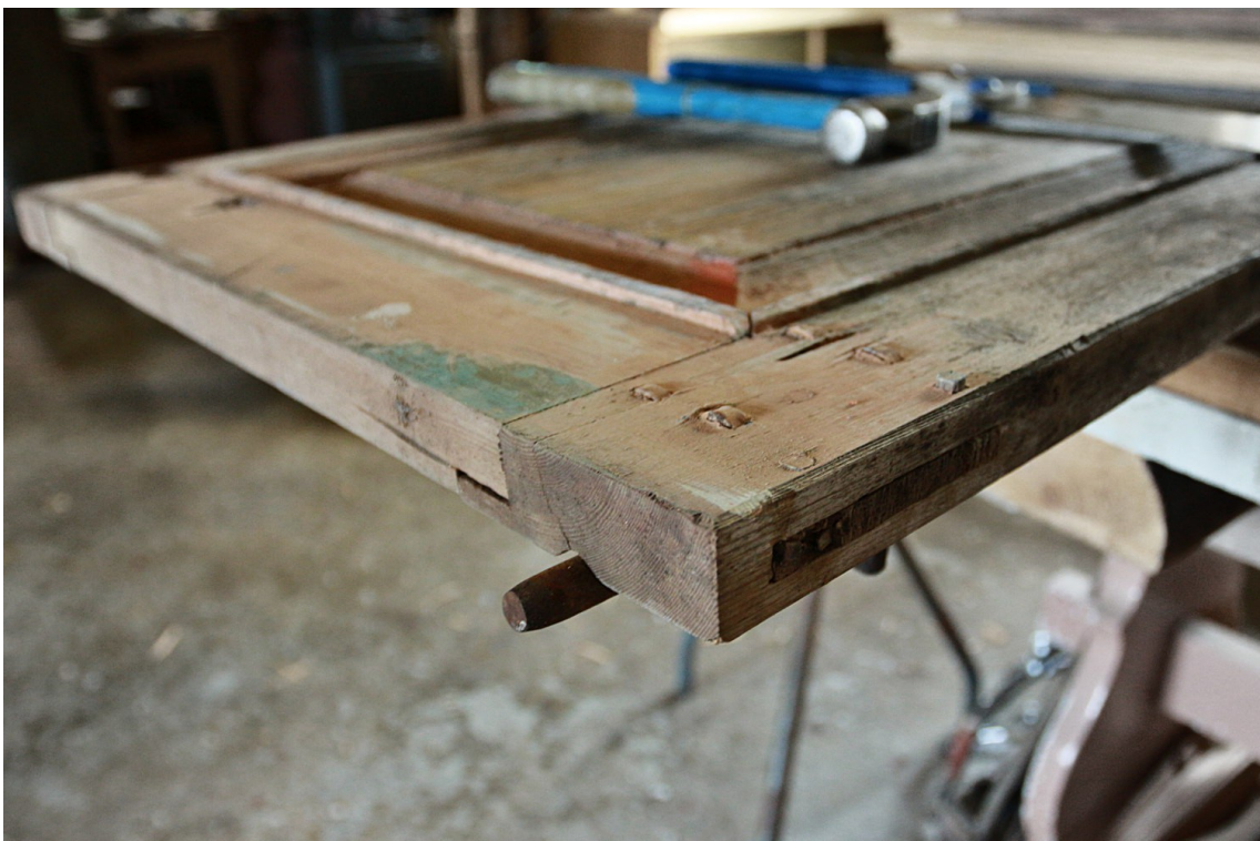
Kuva 5: Ovien kehysten tapitukset on tehty tavanomaista vaativammin liitoksin.
