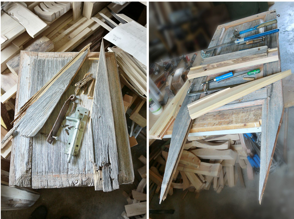
Kuva 17: Ovi purettuna. Koko ovea ei purettu, koska se olisi ollut käytännössä turhaa ja vain kuluttanut vanhoja rakenteita. Vasemmalla alapeili sekä jäänneet kehyksen aikaisemmasta paikkauksesta. Helat on myös irroitettu. Oikealla uusien osien sovitusta.
