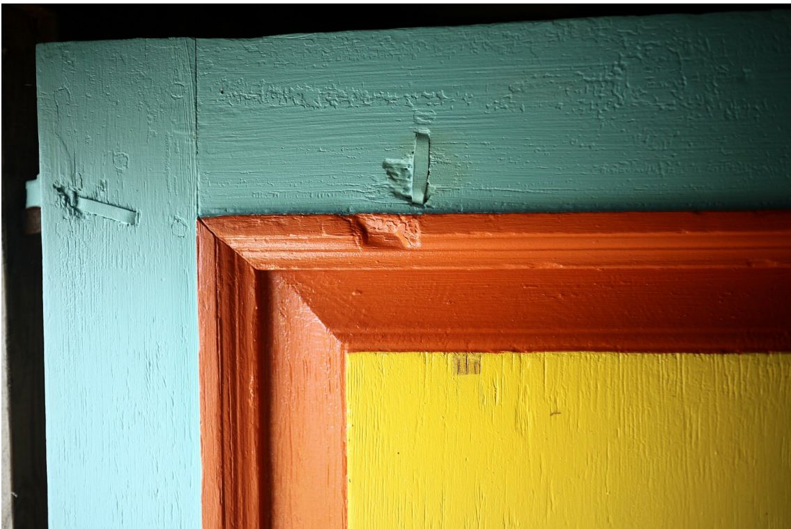
Kuva 25: Keltainen oli säilynyt kaikkein huonoimmin, mutta siitäkin jäi näkyville pieni esimerkki toisen ovipuoliskon yläpeilin yläreunaan.
