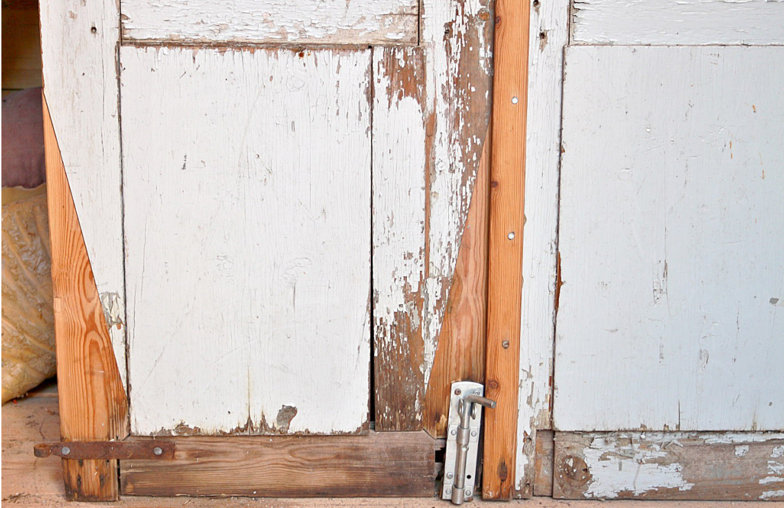
Kuva 6: Ovia on korjattu nähtävästi museolle siirron yhteydessä, jolloin toisen oven kehyksen tapitusta ei ole vaivauduttu tekemään alkuperäisen mallin mukaan, vaan yksinkertaisemmin, jolloin alaliitoksessa 45 asteen jiiri on syntynyt myös oven sisäpuolelle, kun se alkuperäisessä liitoksessa on vain ulkopuolen koristelistan yhteydessä (vrt. kuvan oikeanpuoleinen ovi).
