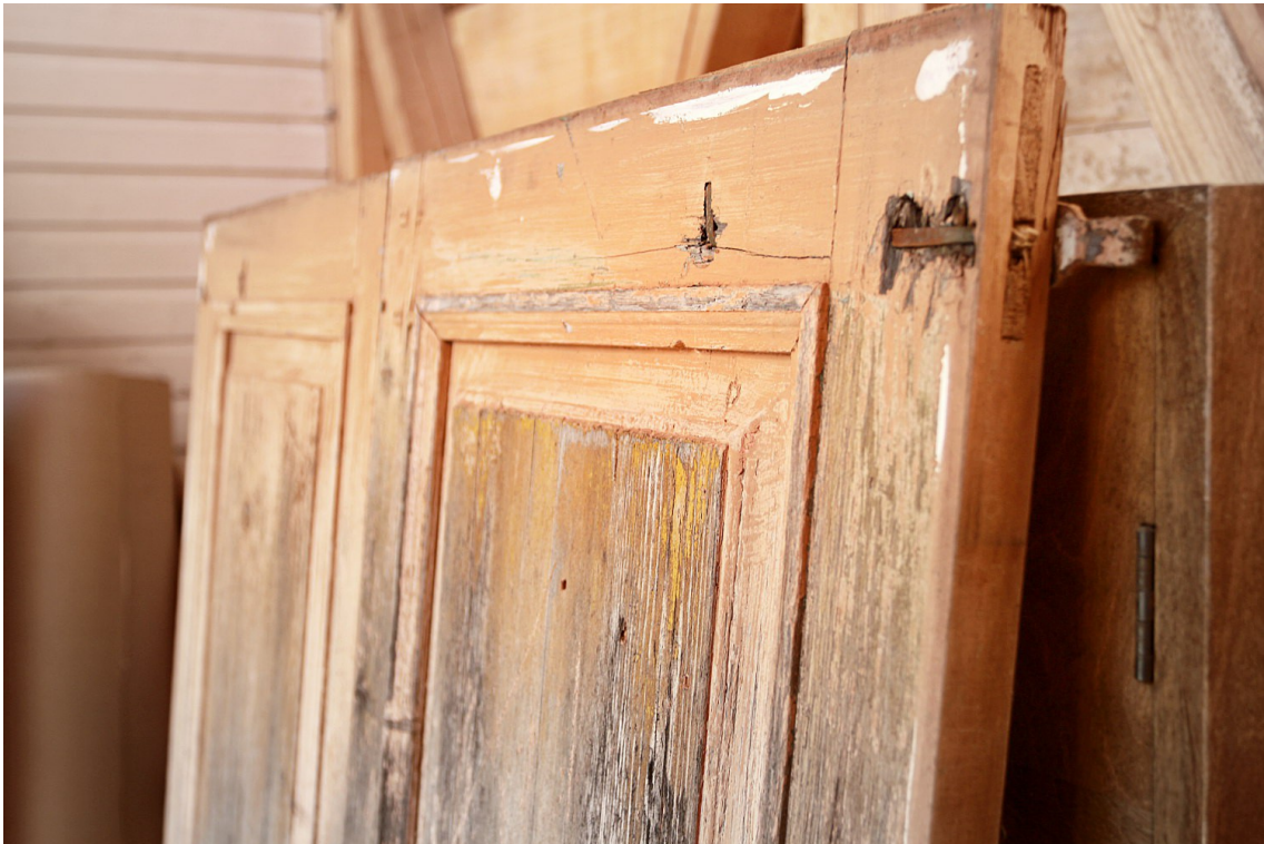
Kuva 4: Ovien peilikenttiä ympäröivät koristeprofiilit on tehty työläästi kehyksen pinnasta ulkoneviksi.
