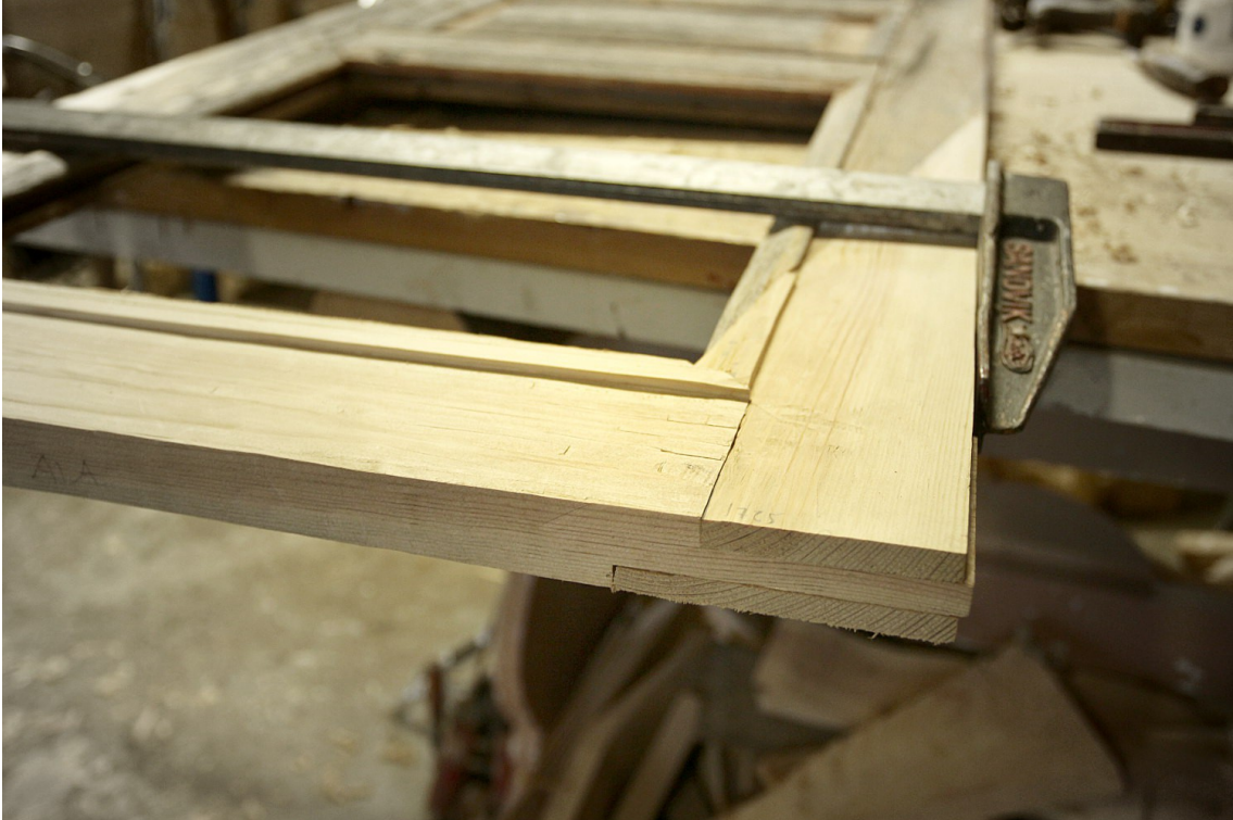
Kuva 18: Kehyksen uudet osat paikoillaan. Koska ovea ei purettu kokonaan, täytyi kehyksen alapuun lovi tehdä alhaalta avoimena, jotta palan sai paikoilleen. Alkuperäisen idean mukainen tapin muotoilu kopiaitiin muilta osin.
