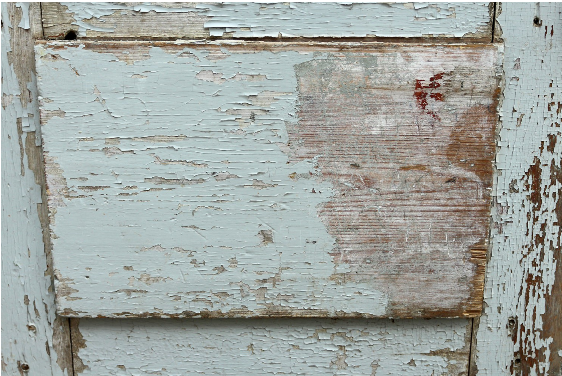
Kuva 14: Sisäpuolella ovissa on karhealla siveltimellä maalattua valkoista, sitten on ainakin kahta eri harmaata, joista pinnalla oleva Miranol-tyyppistä kiiltävää maalia, mahdollisesti jopa lattiamaalia. Toisen oven keskipeilistä löytyi myös kuvan punainen maaliläikkä, joka on kuitenkin ilmeisesti vahinko, koska samaa sävyä ei näkynyt missään muualla.
