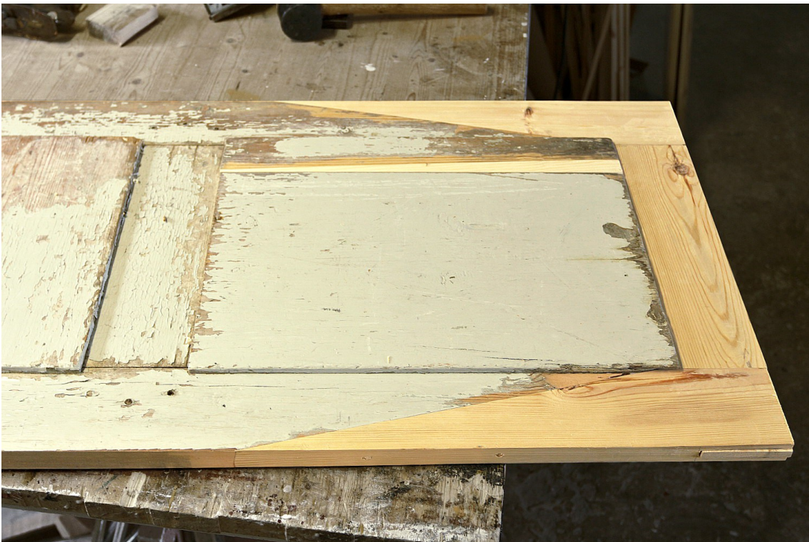
Kuva 19: Paikattu ovi sisäpuolelta. Peilin saumakohdassa oli lahoa, joka korvattiin myös terveellä puulla.
