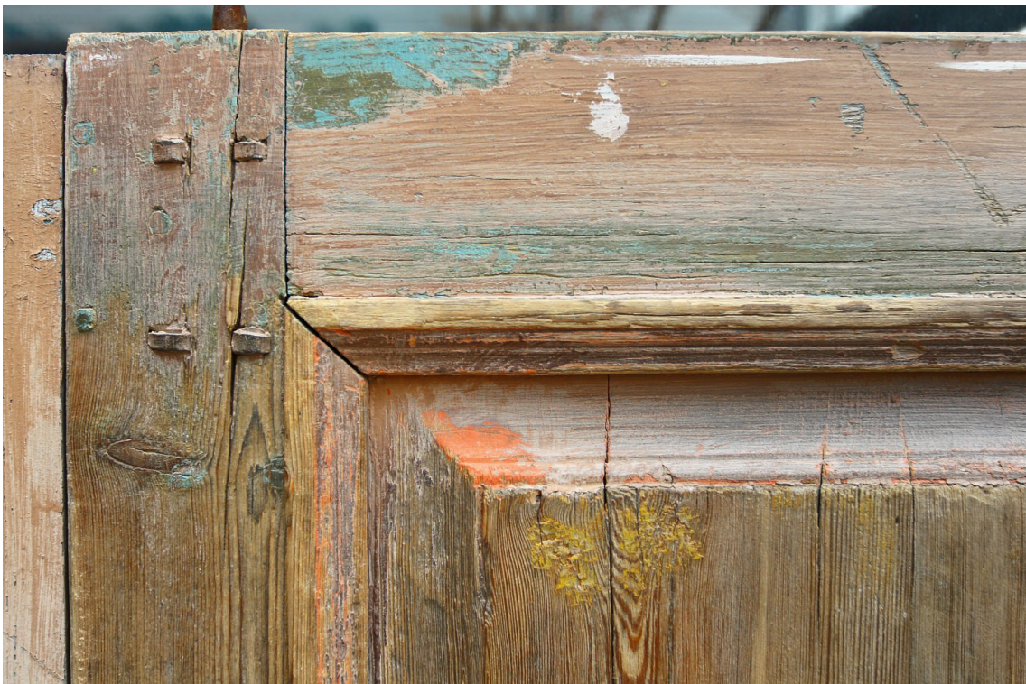
Kuva 8: Ovien alin maalaus paljastui yhden tai kahden päälläolevan kerroksen alta. Maalia oli säilynyt ainoastaan ovien yläosissa. Alla oleva väritys on kirjava: sininen kehys, oranssinpunaiset peilikenttien ympärökset ja varsinainen peilikenttä keltainen. Päälimmäinen maalikerros on kauttaaltaan vanha roosa. Näiden välillä saattaa olla ohut tumma metsänvihreä kerros. Kuvassa näkyvät myös oven yläsalvan kiinnitysnaulat, jotka on käännetty kauniisti oven ulkopuolella. Valkoiset maalinroiskeet ovat tulleet karmia maalattaessa.
