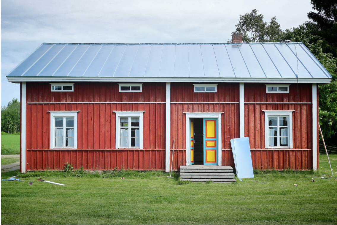
Kuva 1: Palolan tuppa ja sen ovet kunnostuksen jälkeen kesällä 2016. Samaan aikaan talon katemateriaalia oltiin vaihtamassa pärestä pelliksi. Etulape on tässä kuvassa jo valmistunut.
