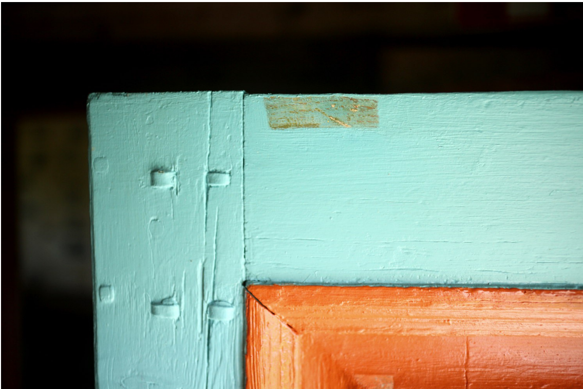
Kuva 23: Yläreunaan jätettiin kurkistusluukut alimmaisista värikerroksista. Ne tulivat parhaiten säilyneille alueille, joten niiden paikat vaikuttavat epämääräisiltä. Kuvassa turkoosi värisävy.
