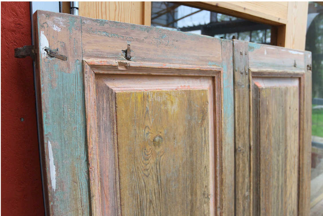
Kuva 21: Ovista poistettiin vain irtoava maali, ja kaikki harmaantunut puuaines hiottiin ja raaputettiin pois, jotta uusi maali tarttuisi puuhun. Tämän verran jäi jäljelle, ja sen annettiin jäädä tulevien korjaajien iloksi.
